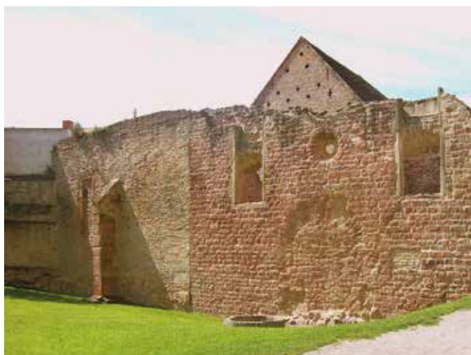
Außenwand des Judenhofs in Speyer.
