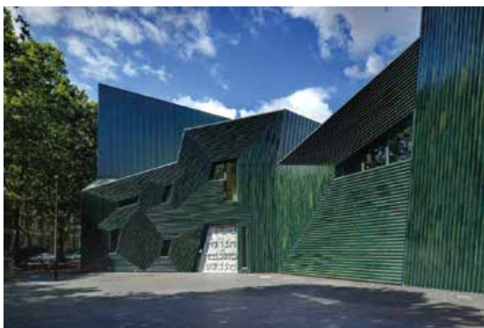
Neue Synagoge Mainz von Architekt Manuel Herz.
