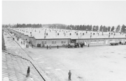
Das Konzentrationslager Dachau kurz nach der Befreiung durch die Amerikaner.
