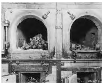
Verbrennungsöfen kurz nach der Befreiung.
