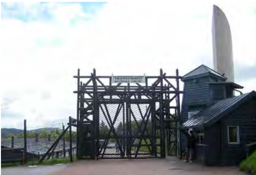
Eingang ins Lager. Dahinter das Mahnmal für die Deportierten.
