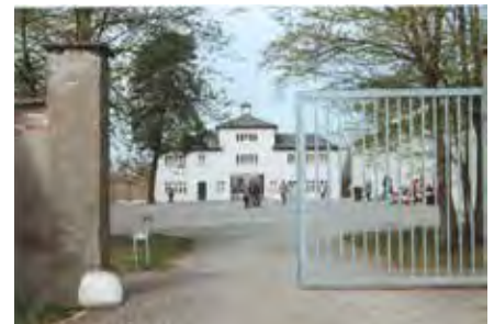
Eingang zum Lager, Turm A.
