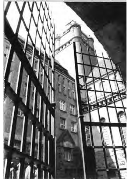
Blick in den ehemaligen Richthof des Landgerichts (1990).
