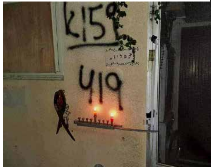
Soldaten haben nach dem 7. Oktober 2023 Chanukka-Kerzen am zerstörten Haus von Adi im Kibbuz Holit entzündet.
